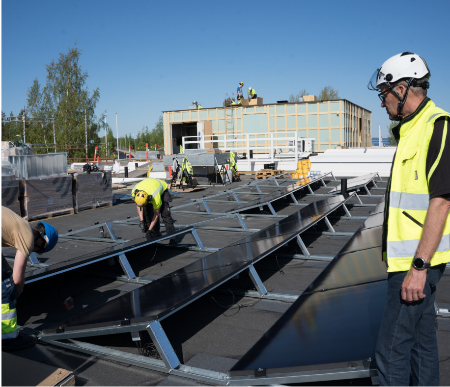
Samiedun kiinteistöpäällikkö Jari Tavi seuraa aurinkopaneelien asennusta Paviljongin kampuksen katolla.
